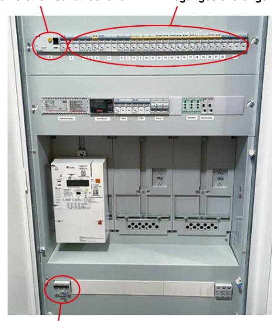
Vorzählersicherung / Tarifschalter
